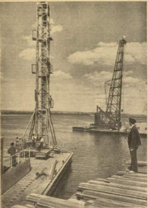
Началась забивка металлического шпунта в перемычу.
